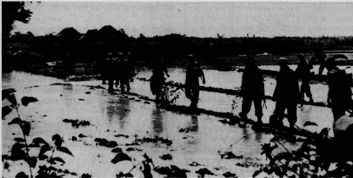
Afb. 2 Patrouillegang in de sawah
